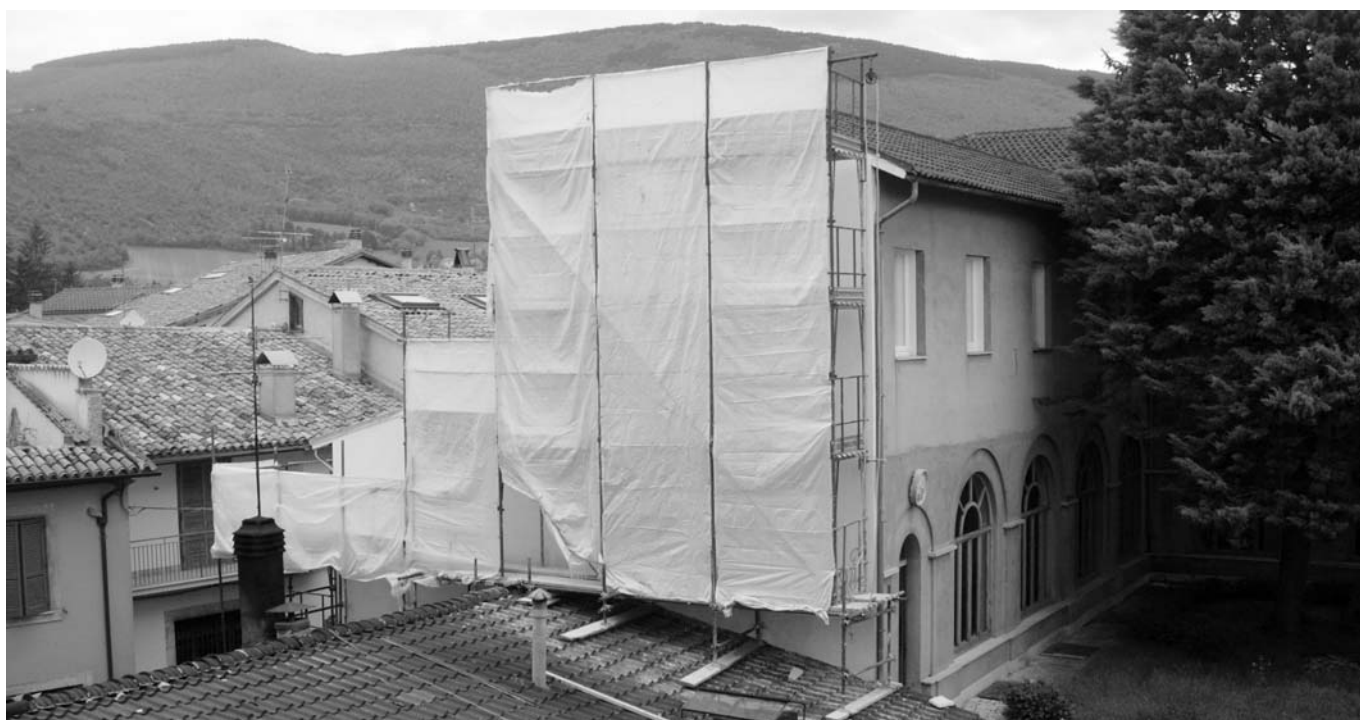
Ponteggi a copertura del tetto del Noviziato durante le riparazioni
